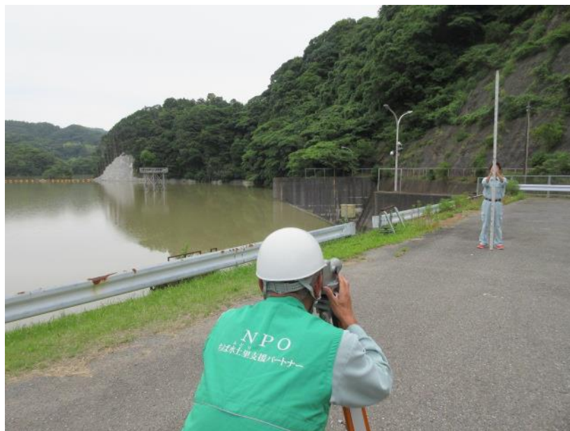
安房中央ダムの堤体観測状況
